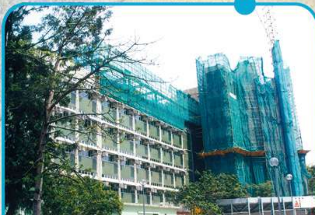
新翼校舍擴建工程動工
