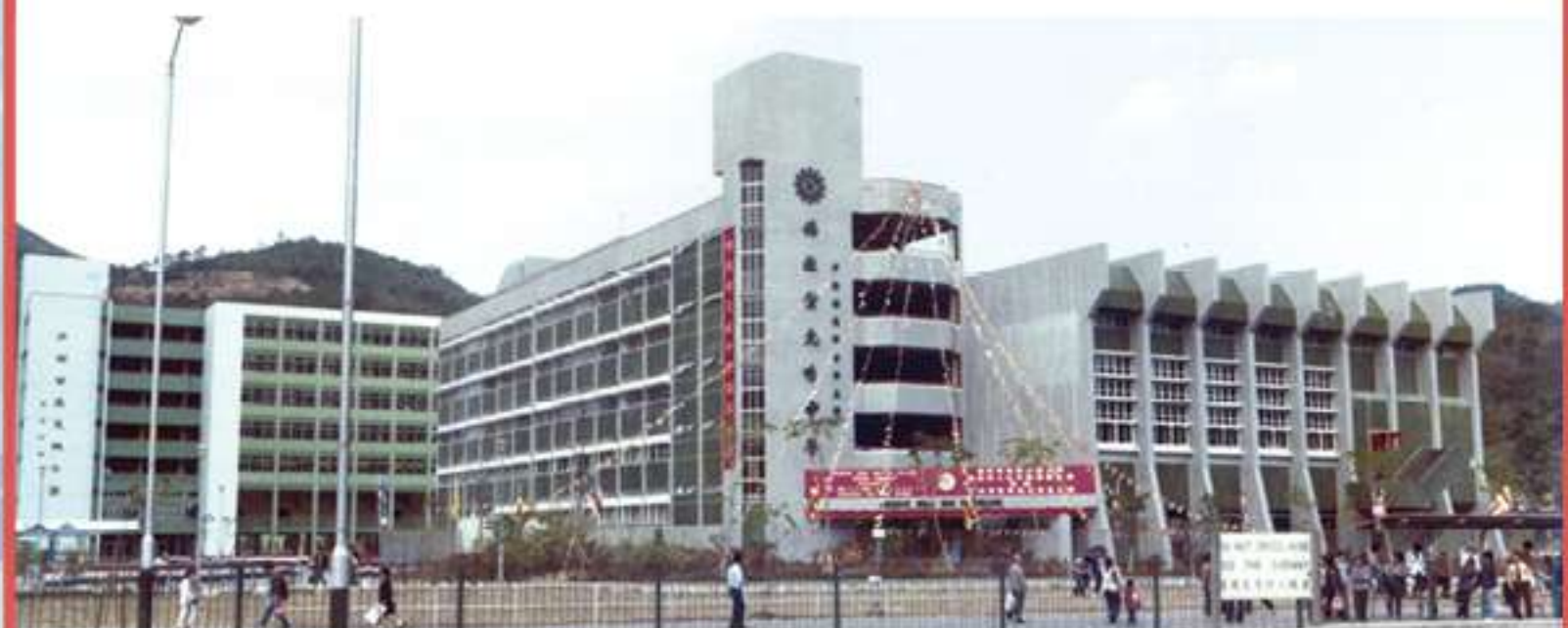
二月接收竣工校舍（美林邨現址）。四月十一日，正式遷入新校舍
