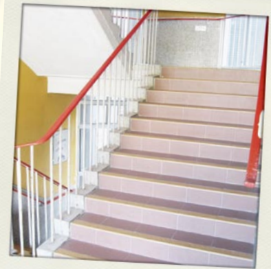
鋪上新地磚的樓梯
